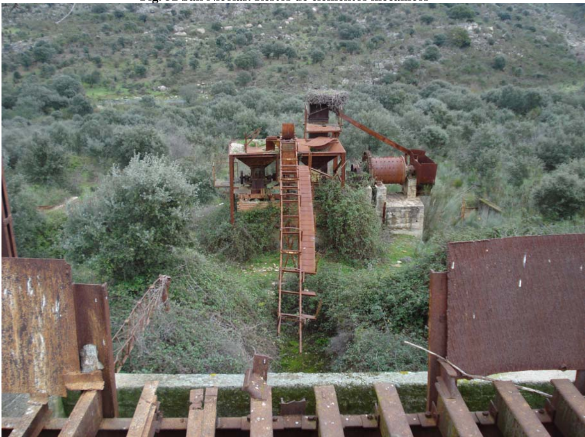
Fig. 53 Grupo minero Tres Arroyos. Planta de concentración
