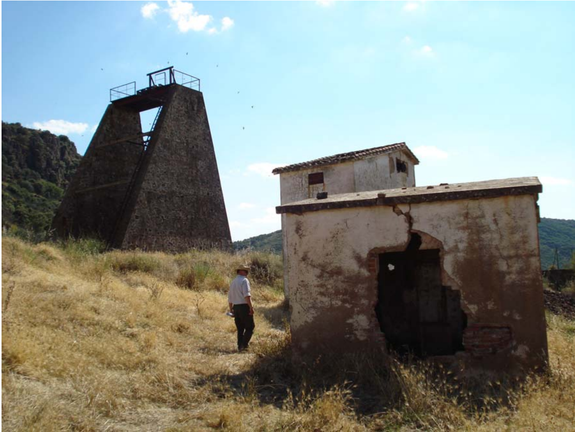
Fig. 60 Mina Alfredo. Castillete-cabria
