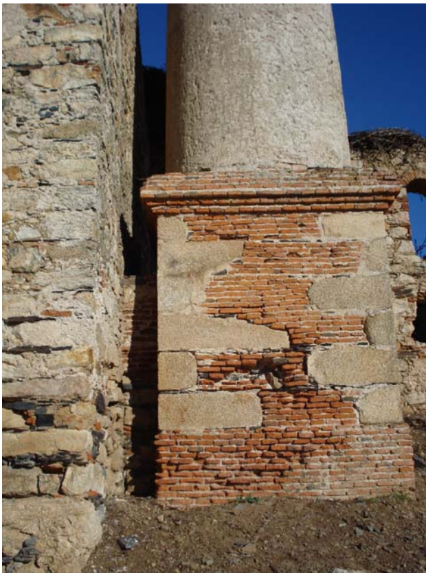
Fig. 17 Chimenea de sección circular
