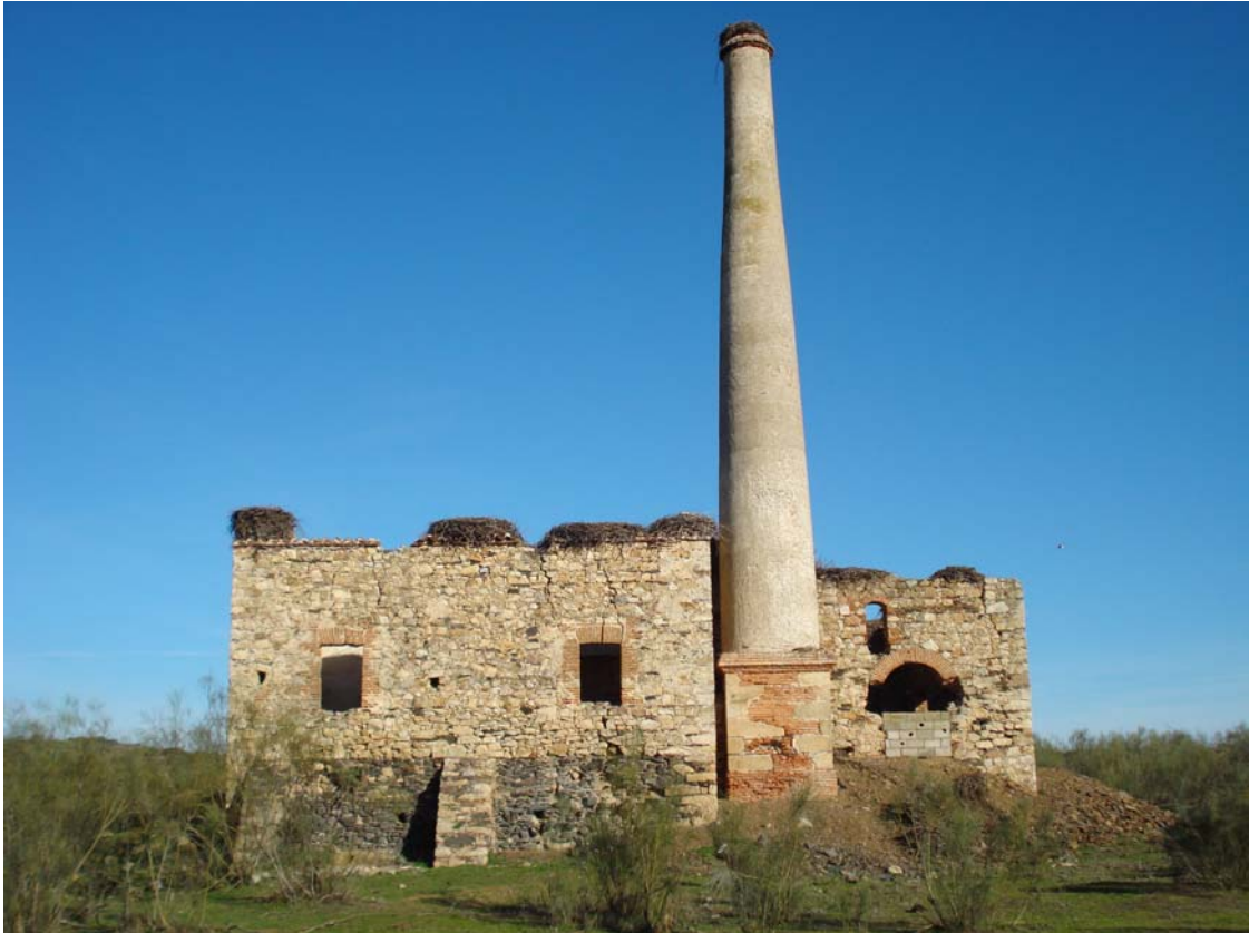
Fig. 15 Casa de máquinas de mina La Liebre
