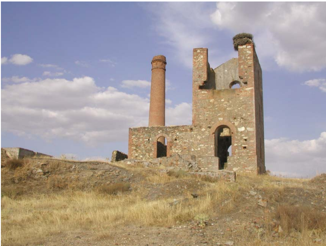
Fig. 16 Casa de máquina Cornish .Santa Catalina
