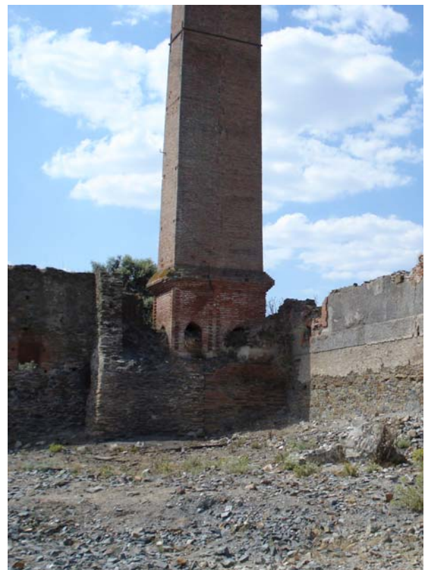
Fig. 18 Chimenea de sección cuadrada
