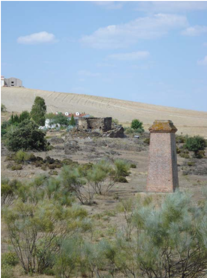
Fig. 26. Chimenea de ventilación
