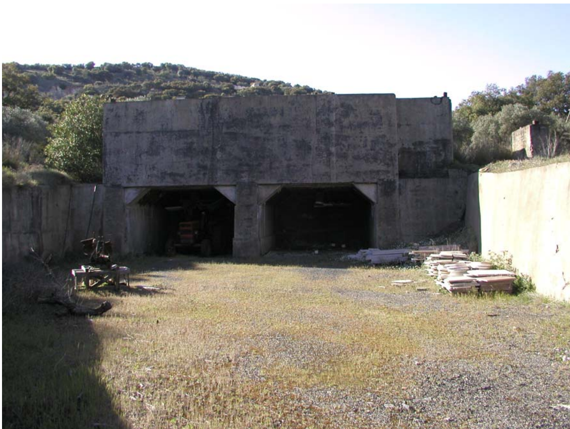
Fig. 55 Mina Monchi. Tolvas de carga
