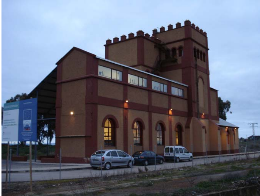
Fig. 48 Aldea Moret. Instalaciones Abundancia
