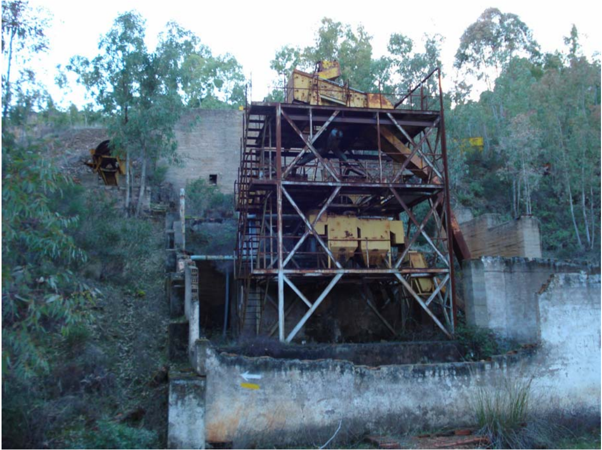
Fig. 52 San Nicolás. Restos de elementos mecánicos
