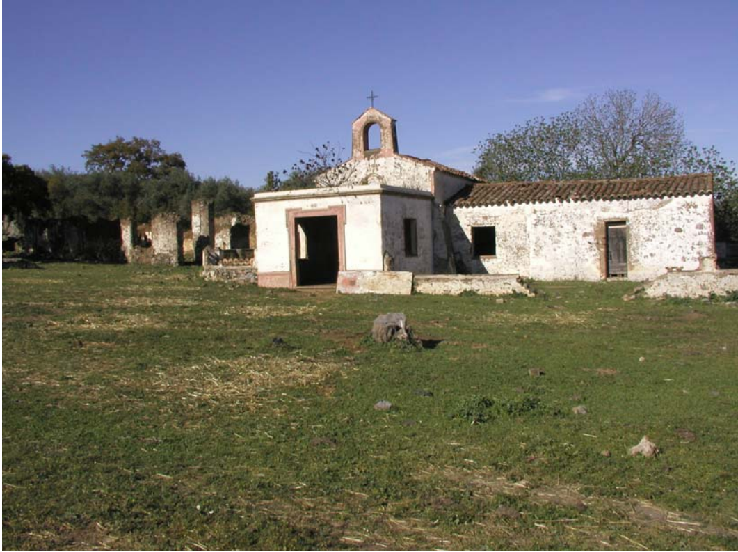
Fig. 56 Mina Monchi. Edificios auxiliares. Capilla
